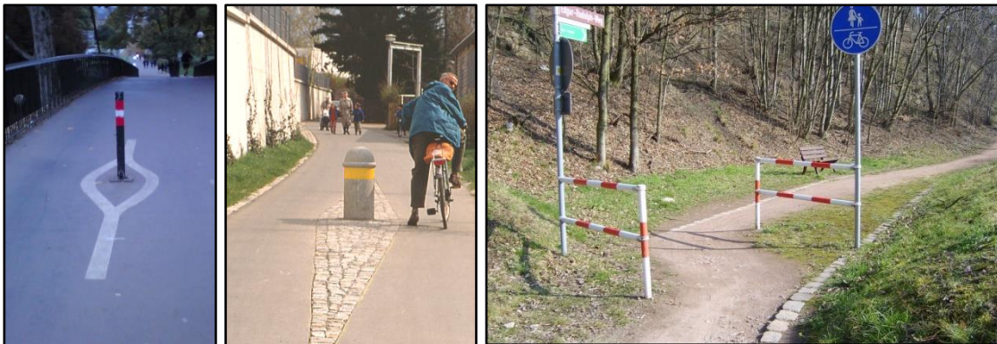
Abb. 52 Beispiele für die Reduzierung von Konfliktpotenzialen an Pollern / Umlaufsperrern
