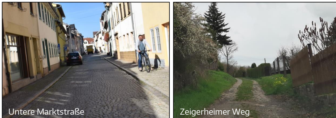
Abb. 12 Oberflächendefizite in Bad Blankenburg
