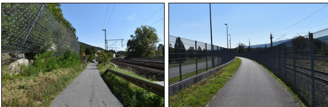
Abb. 3 Bestandssituation Saaleradweg (Remschütz – Schwarza)
