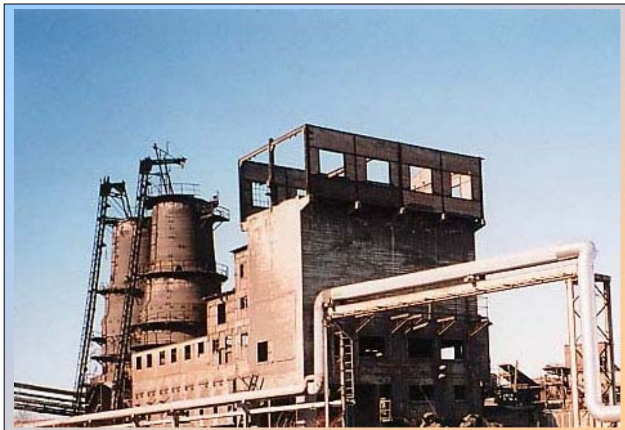
Abb. 4: Maxhütte Unterwellenborn: Abrissmaßnahmen
